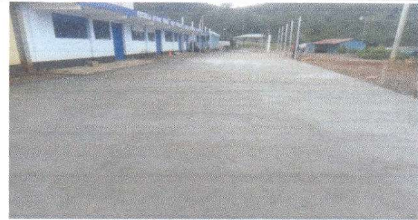
Foto 4: Reparación de plancha de concreto de patio.
