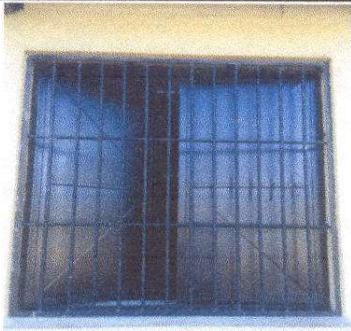
Foto 3: Fabricación e instalación de de ventana de metal.
