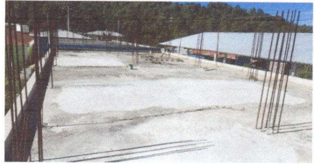
Foto 2: Reparación de pañuelos.
