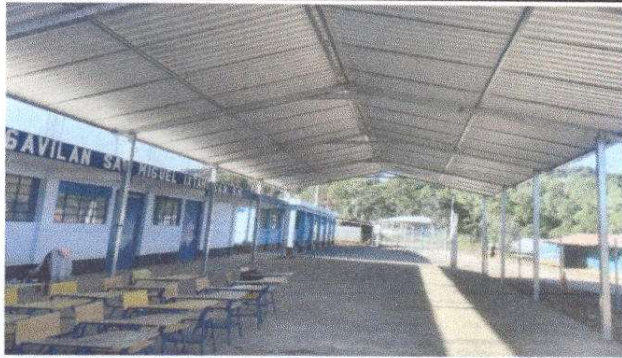
Foto1: Sustitución de lamina por lamina troquelada aluzinc calibre 26, sustitución de estructura de soporte de metal por metal.
