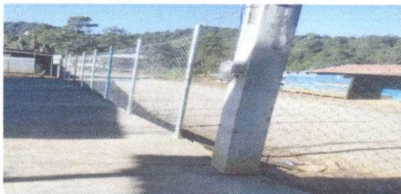
Foto 5: Reparación de tubo HG y malla galvanizada.
